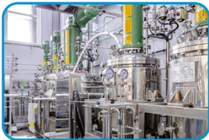
Зона приготовления формовочного раствора
